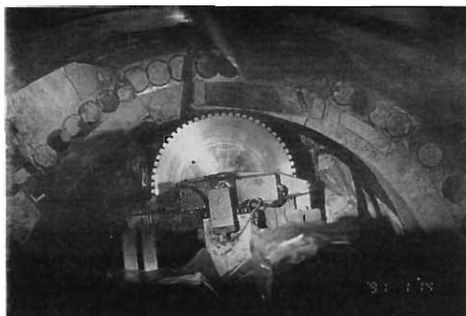
写真 生体遮蔽体機械的切断の状況
